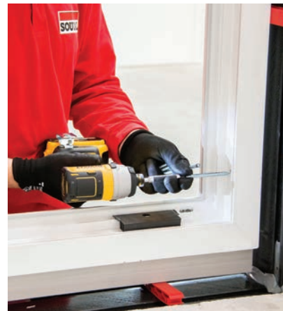
14 Fije la ventana mecánicamente
