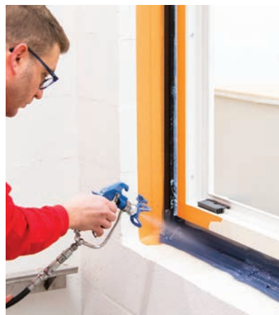
16 Haga que la parte interna sea estanca al aire con, por ejemplo, Soudatight LQ / SP
