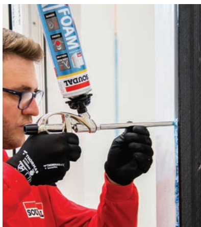
15 Retire las pinzas y cierre la junta de conexión entre el marco y la ventana
