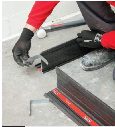
03 Coloque las uniones angulares
