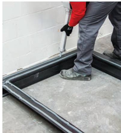
08 Coloque la cola de forma continua, en 2 tiras, en el bastidor
