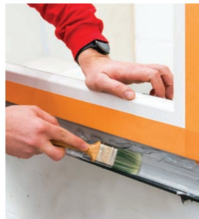
17 Haga que la parte externa sea estanca al aire y a las lluvias fuertes con, por ejemplo, Soudatight Hybrid
