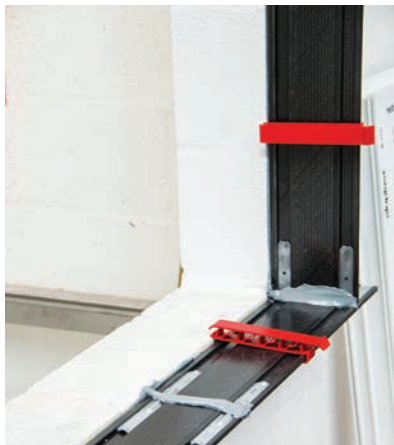
12 Selle las esquinas internas y coloque los muelles SoudaFrame SWI
