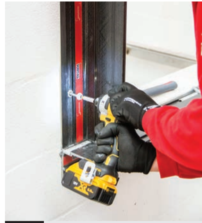
11 Fije el marco contra la pared con los tornillos y tacos adecuados
