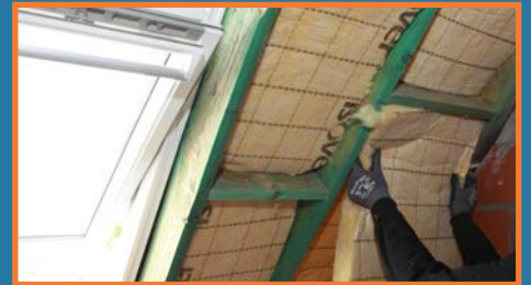
Acabado de techos interiores
