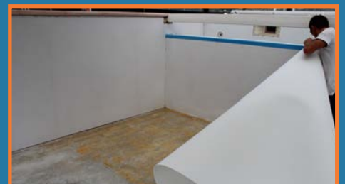
Construcción de piscinas
