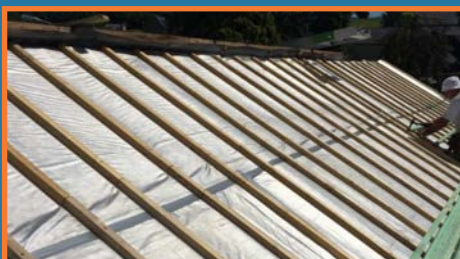
Acabado de techos exteriores
